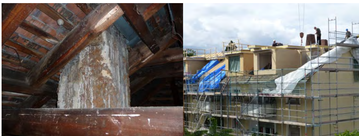
Abbildung 3: Ein vorher nicht ausgebauter Dachstuhl (links), der nach Dachausbau (rechts) und energetischer Dämmung zukünftig als Wohnraum genutzt wird.
